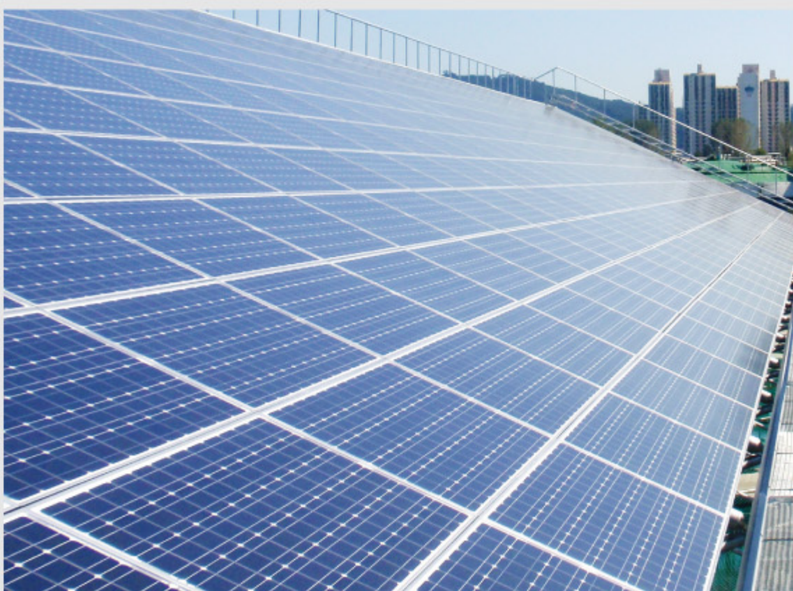
태양광 발전시설 전기 공사
